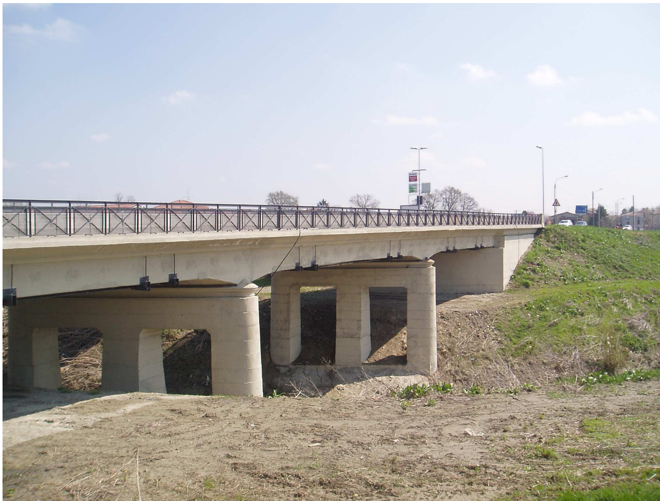
Ponte sul torrente Stirone in località Soragna lungo la S.P. 11 di Busseto al km 16+500 – Ristrutturazione ed allargamento. Ruolo: Progettista e Direttore dei Lavori
