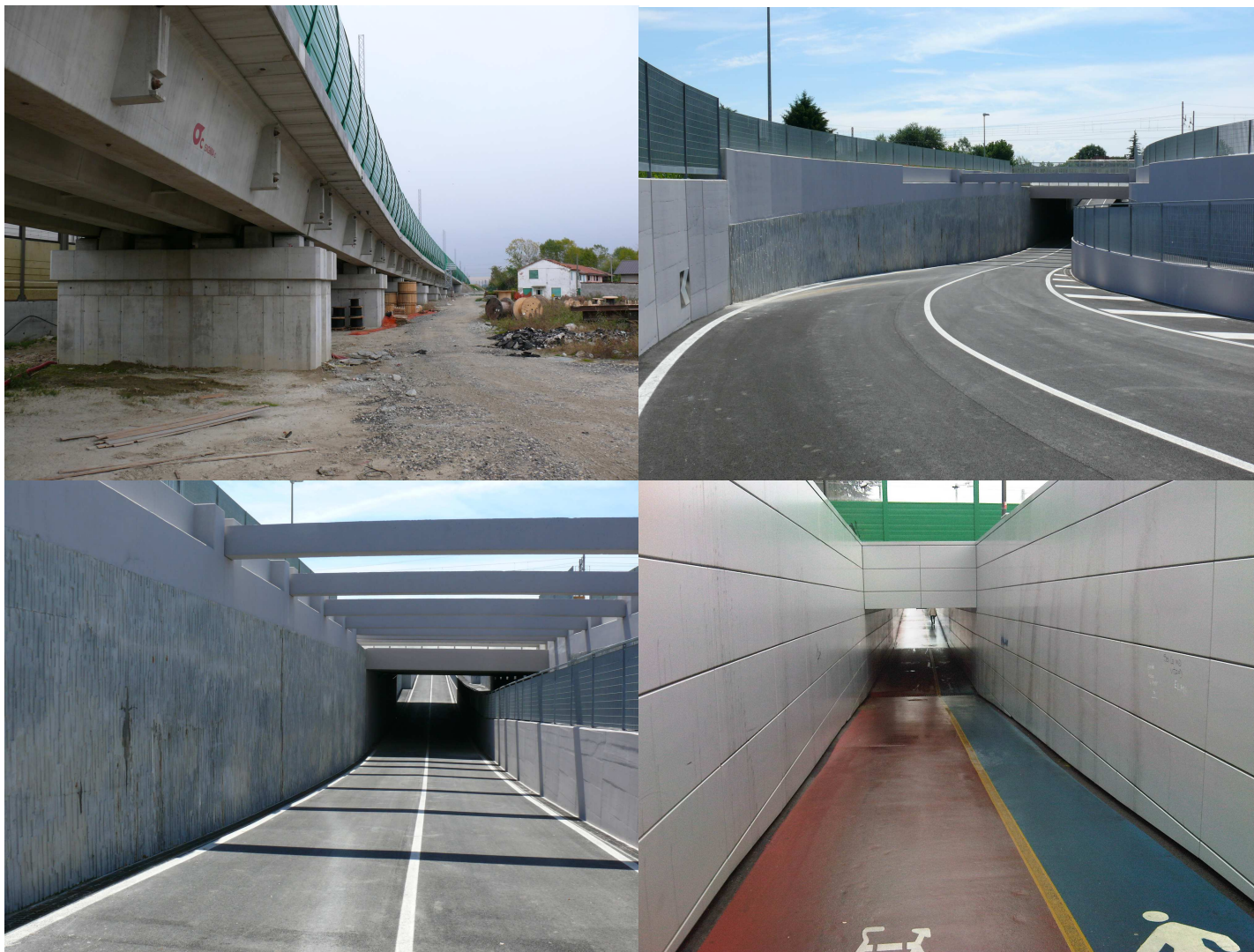
Realizzazione del sistema ferroviario metropolitano regionale nell'area metropolitana diffusa centrale veneta. Tratto Mestre-Castelfranco Ruolo: Progettista delle varianti esecutive e costruttive
