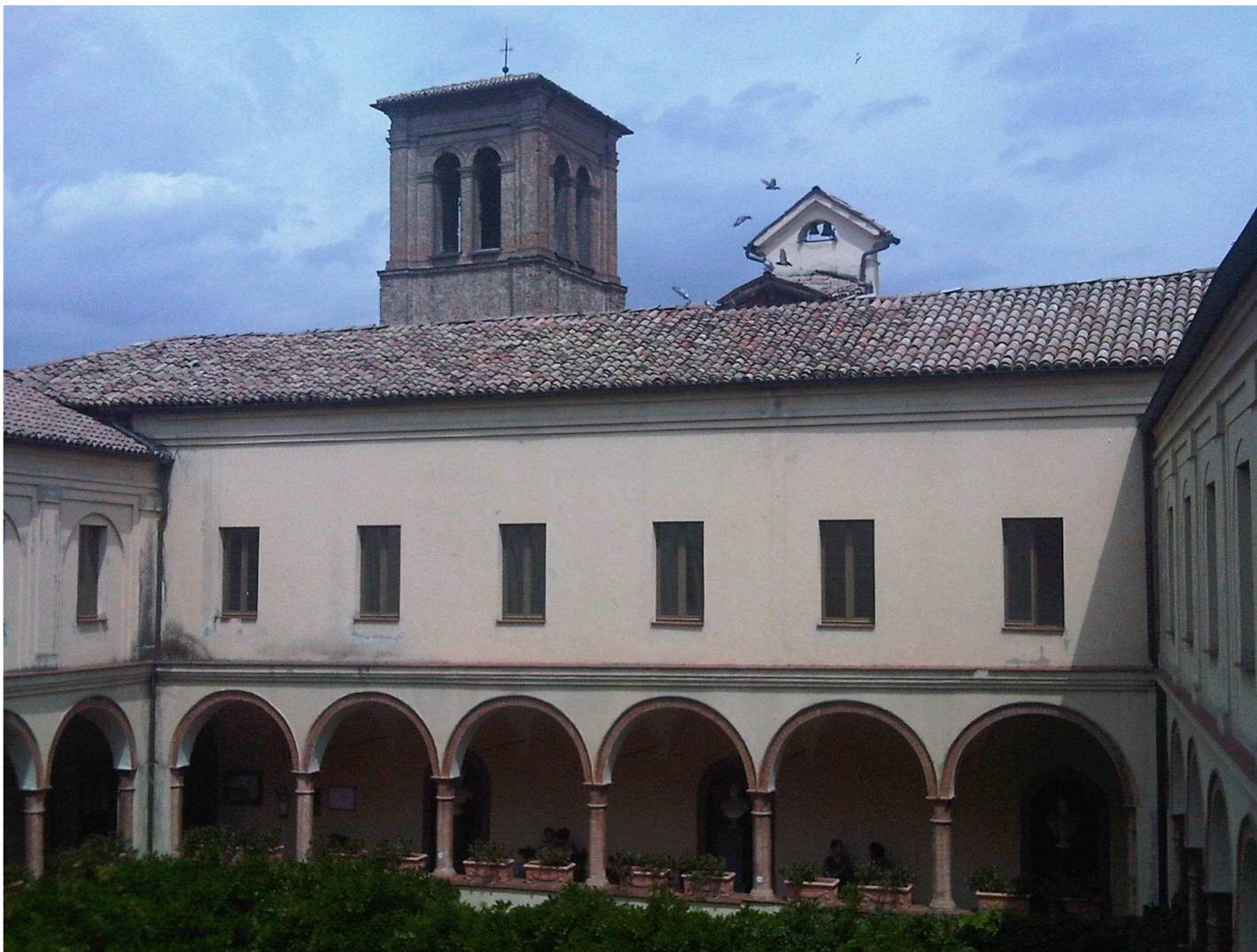
Rifacimento della copertura del Conservatorio A. Boito di Parma Progettazione esecutiva, coordinamento sicurezza, relazione di vulnerabilità sismica e direzione lavori
