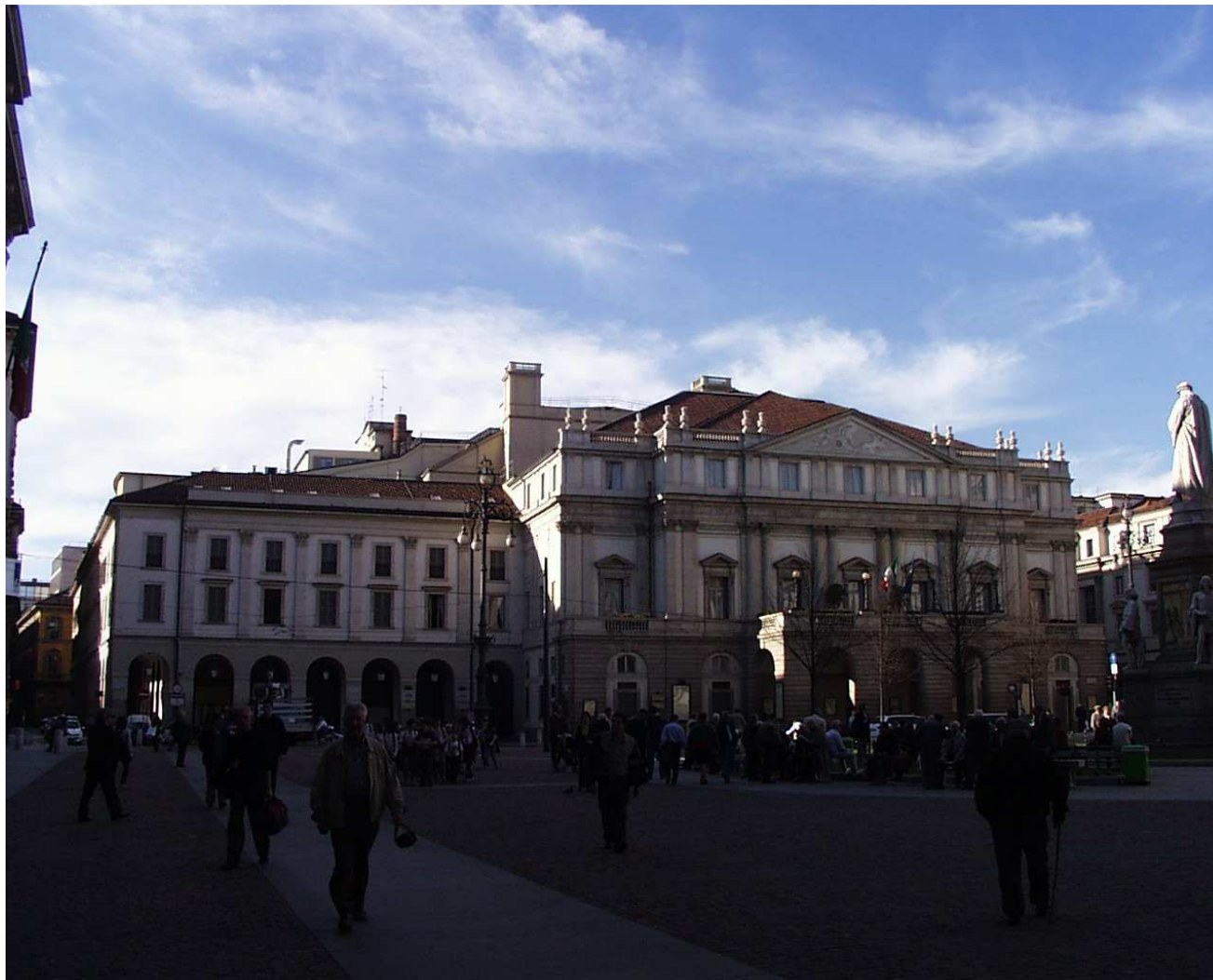
Ristrutturazione del Teatro Alla Scala a Milano Redazione del piano Generale della Qualità e vigilanza in corso d'opera sulla qualità di esecuzione
