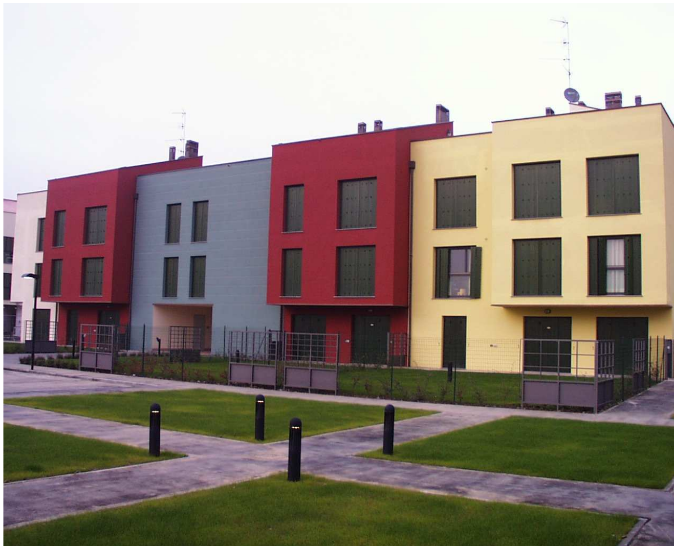
Progetto per la realizzazione del centro residenziale Terziario integrato Papete s.r.l. -: Progetto Strutturale Esecutivo e Direzione Lavori Strutturale per Insediamento Terziario Integrato a Collecchio - Parma
